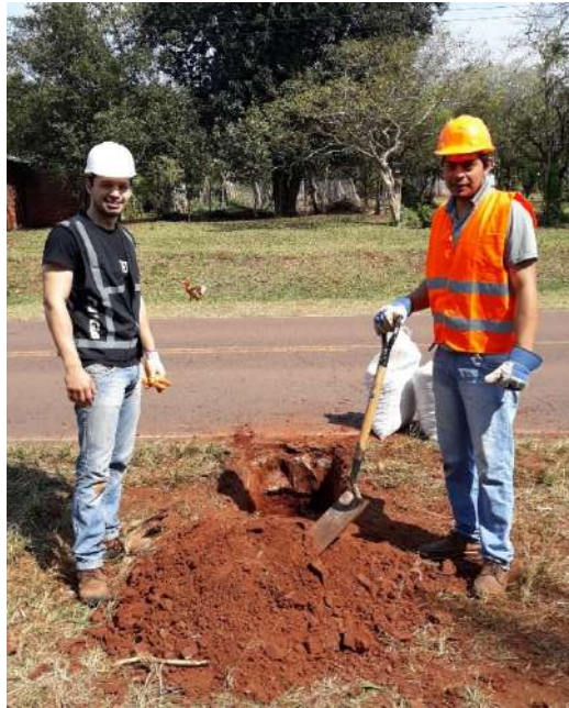
Excavación de Calicata pk: 1+800
