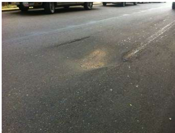
Figura 9- Abultamientos y hundimientos
