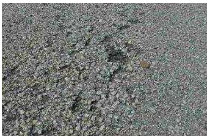
Figura 23 - Desprendimiento de agregados
