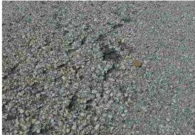
Figura 17- Pulimento de agregados
