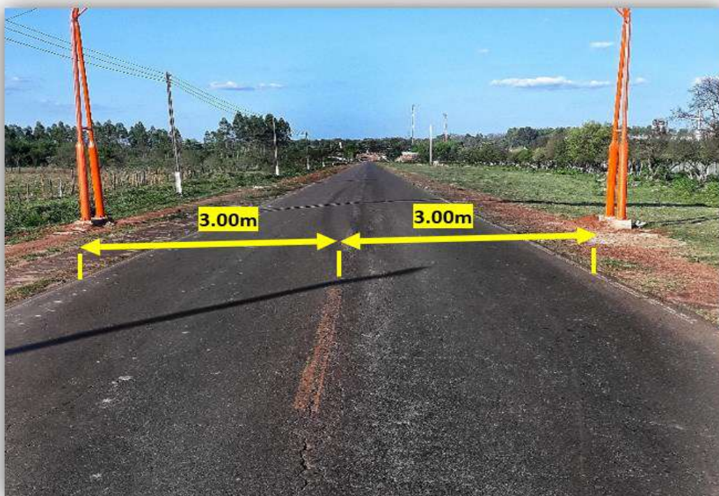
Figura 38 - Ancho de la calzada
