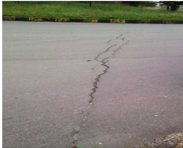
Figura 15- Fallas longitudinales y transversales
