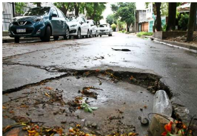
Figura 11- Depresión (hundimiento por asentamiento)
