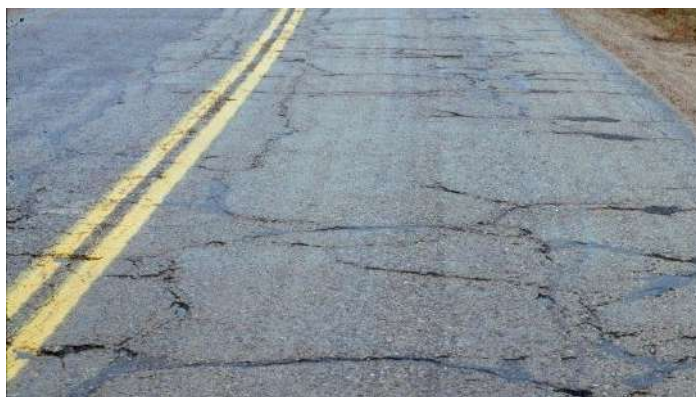
Figura 8- Agrietamiento en bloque
