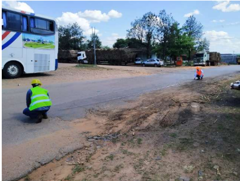
Relevamiento de falla pk:18+450
