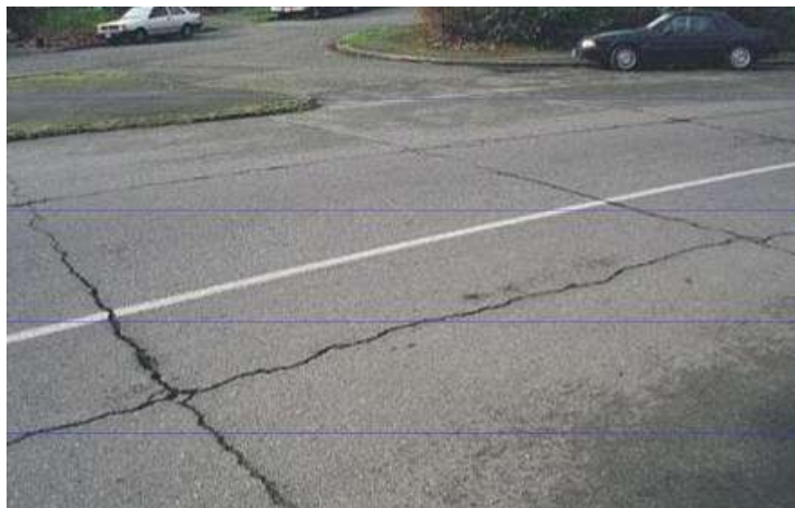
Figura 13- Grieta de reflexión de junta
