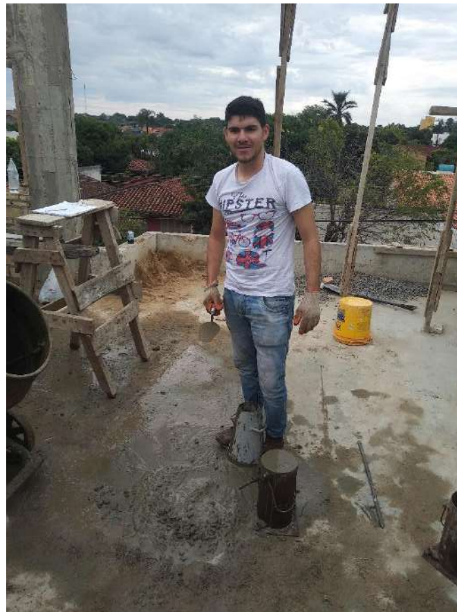
Ilustración 12: Trabajo de muestreo en la obra C-3
