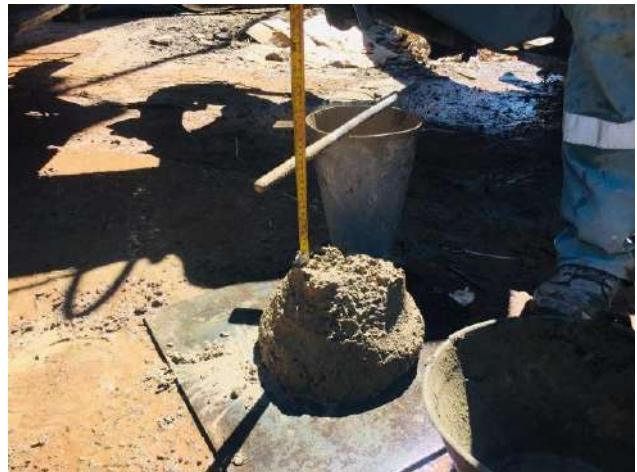
Ilustración 14: Medición del Asentamiento en la obra C-06
