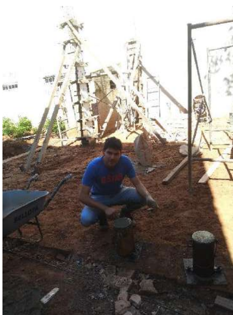
Ilustración 15: Molde de probeta correspondiente a la construcción C-11
