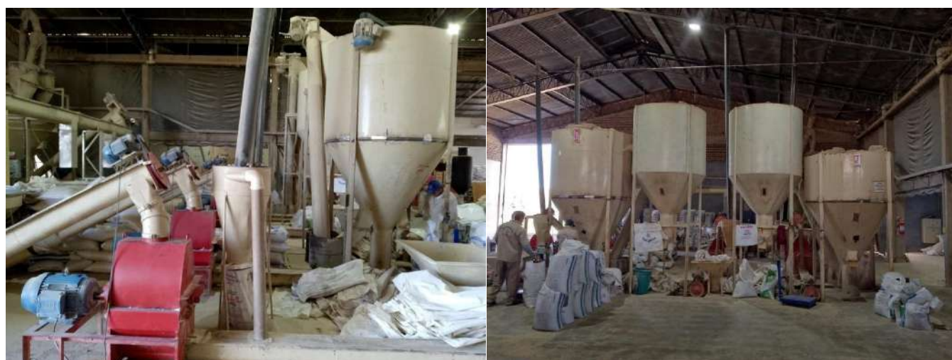
Figura 13: Salida de la mezcladora de balanceados
