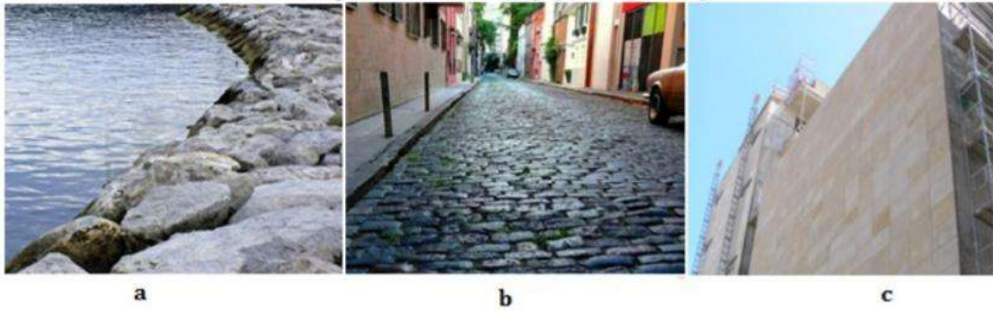
a) Defensas fluviales; b) Vía pavimentada; c) Revestimiento de piedra natural en estructuras nuevas.
