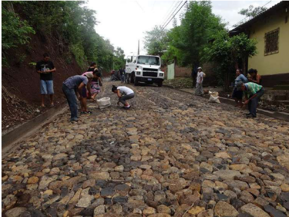
Ilustración 12 Imagen de pavimento tipo empedrado.
