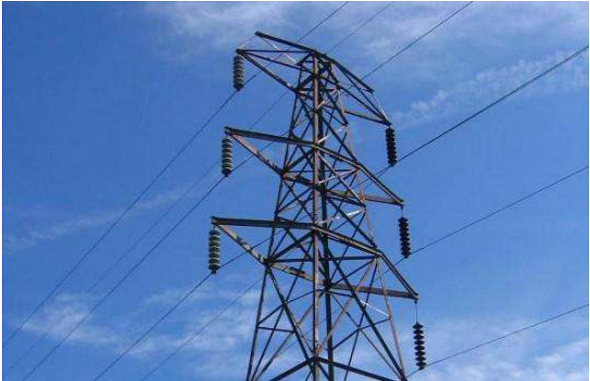
Figura 1. 3: Torre de Suspensión.
