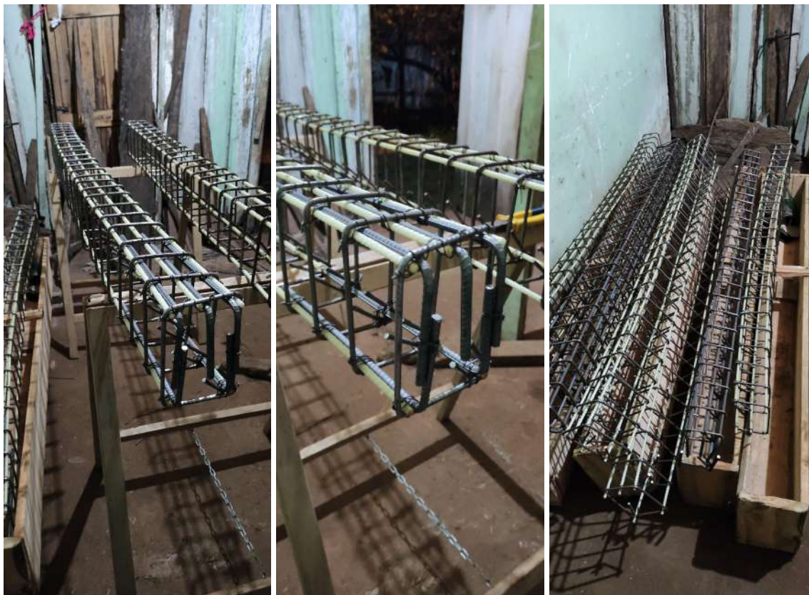
Fotografía 5. Detalle de armado para vigas armadas con PRFV.
