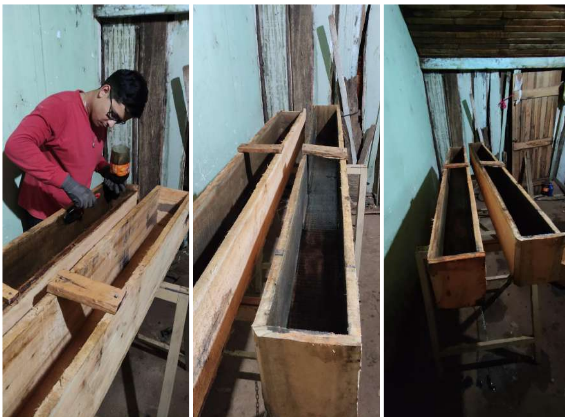
Fotografía 6. Aplicación de aceite para desencofrante.
