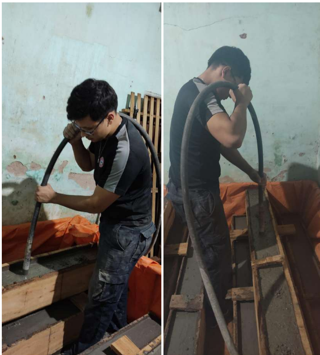
Fotografía 7. Proceso de vibrado en cargamento de vigas.
