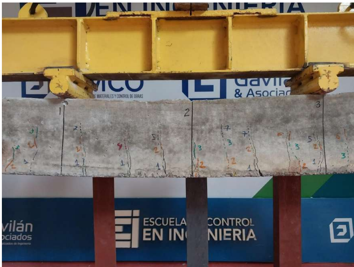
Fotografía 18. Esquema de fisuras en viga con refuerzo de acero.
