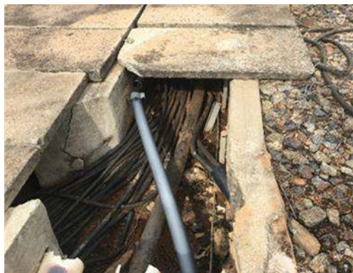
Figura 7.7: Canaleta con conductores
