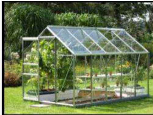
Figura 2. 3 Invernadero Recubierto por planchas de Vidrio
