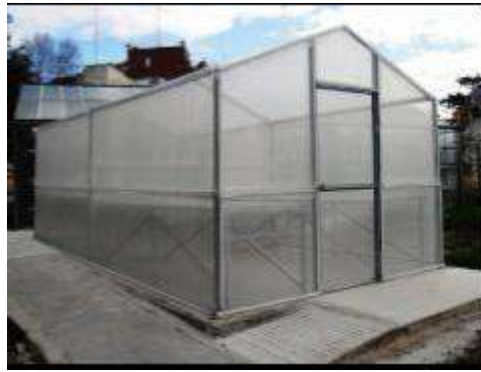
Figura 2. 4:Invernadero recubierto por malla Antivirus
