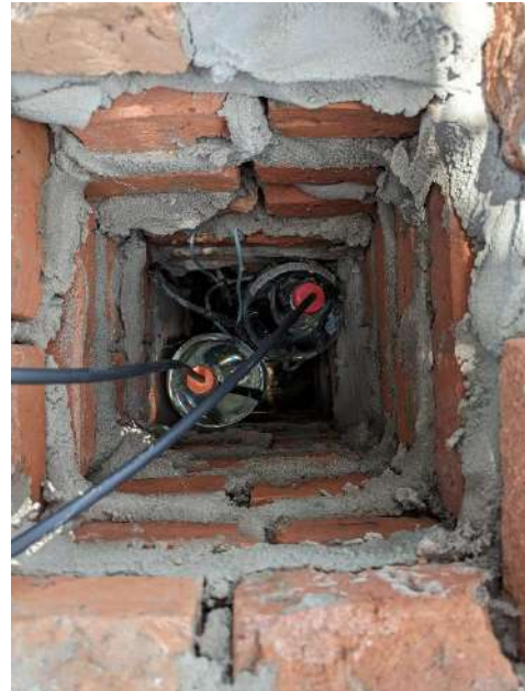
Figura 5.14 Botellas conectadas a las bombas peristálticas, empleadas para la dosificación de correctivos de pH y ácido
