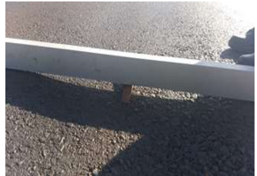
Ilustración 2: Medición del ahuellamiento in situ.
