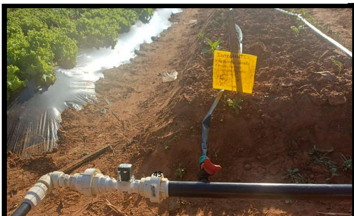
Ilustración SEQ Ilustración \* ARABIC 6 Instalación de cañerías
