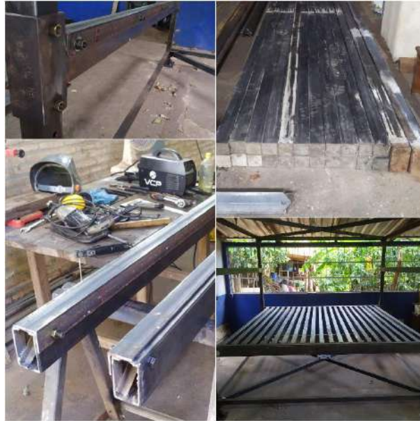
Figura 3. 10 Construcción de la mesa de corte
