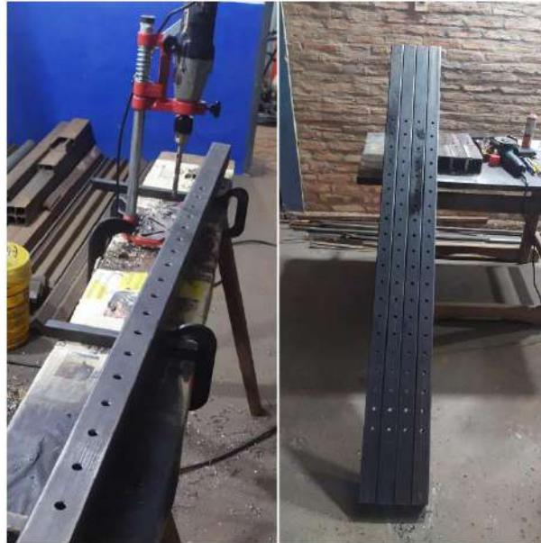
Figura 3. 2 Fabricación de las columnas
