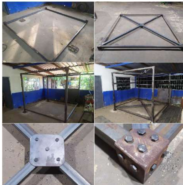
Figura 3. 5 Construcción de tensores
