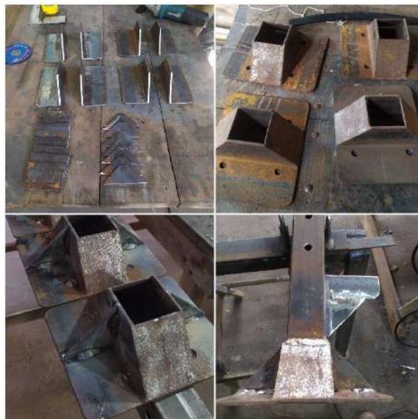
Figura 3. 3 Fabricación de las bases de las columnas
