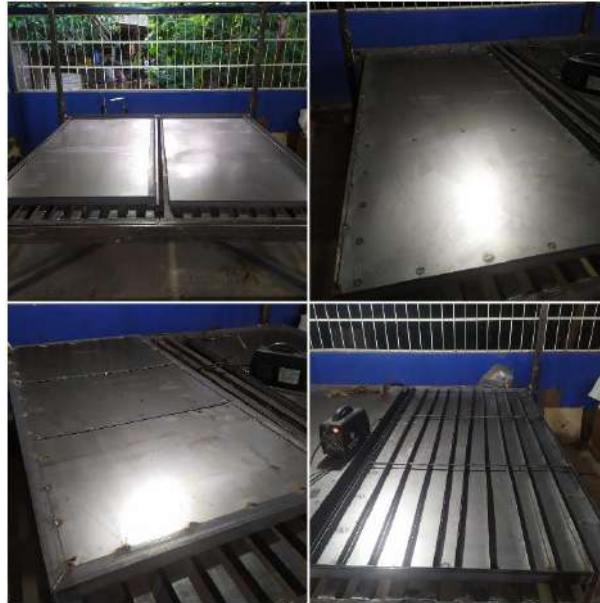
Figura 3. 11 Construcción de la bandeja y rejilla
