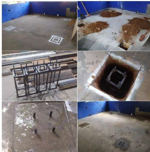
Figura 3. 1 Cimentación de la base
