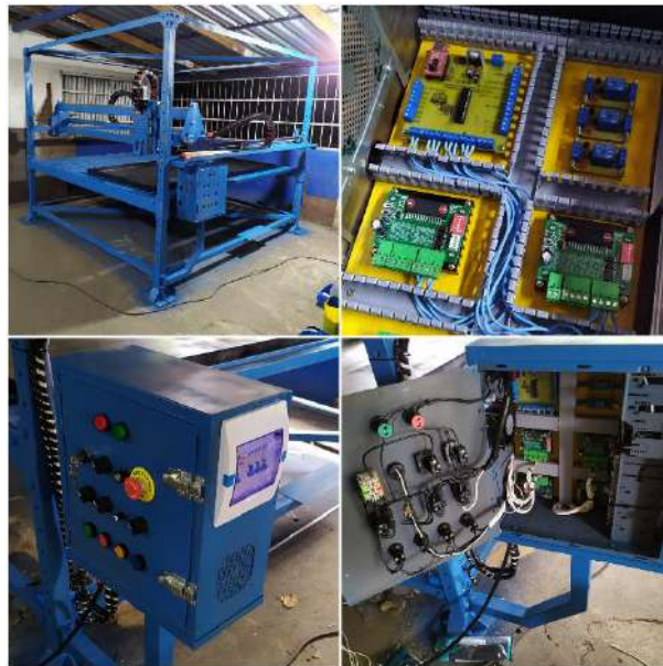
Figura 3. 20 Cableado y Ensamblaje de componentes eléctricos y electrónicos
