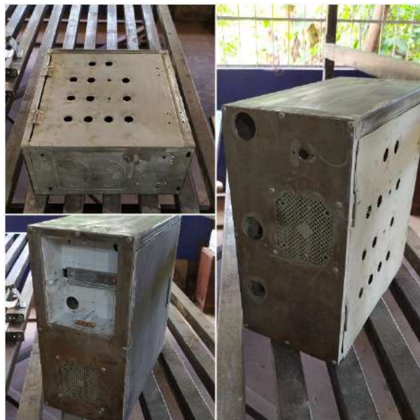
Figura 3. 12 Construcción del tablero
