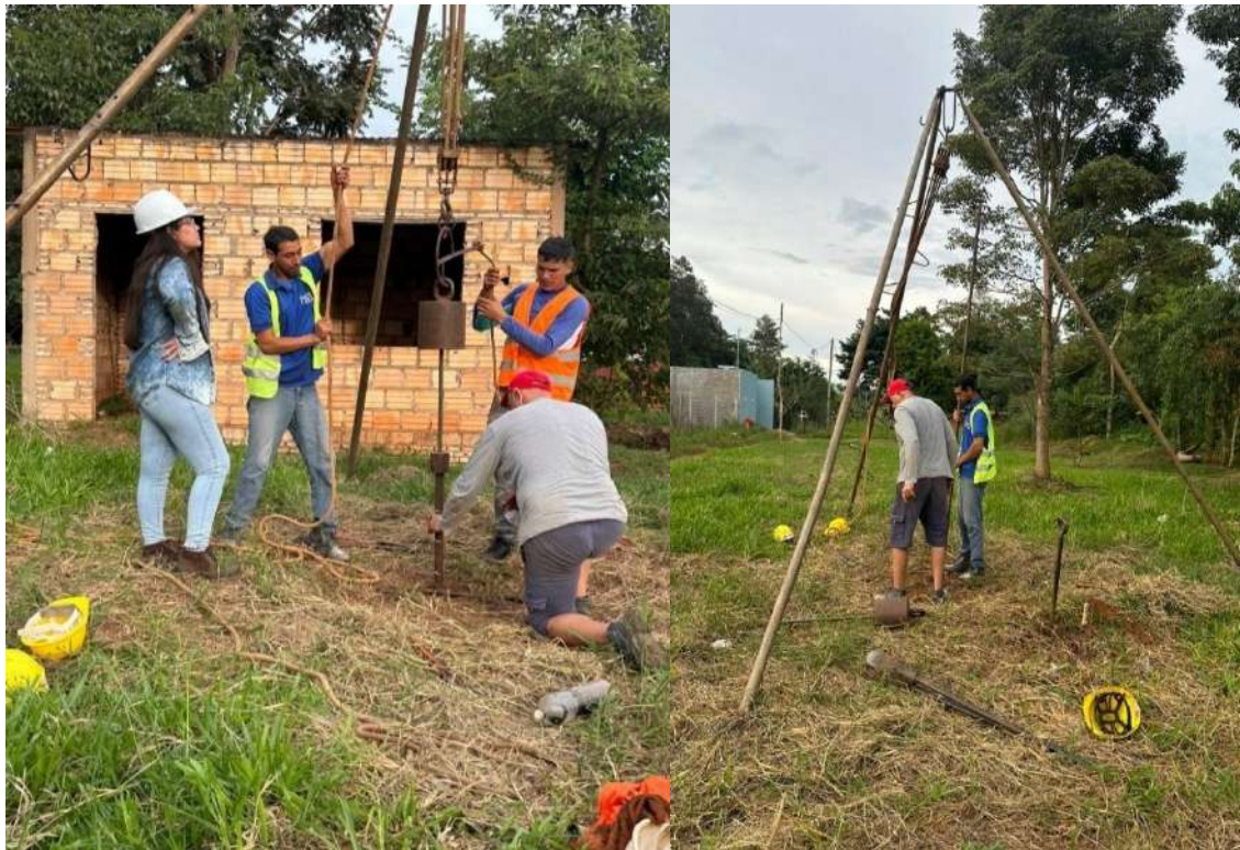
Figura 4: Estudios geotécnicos- Ensayo SPT
