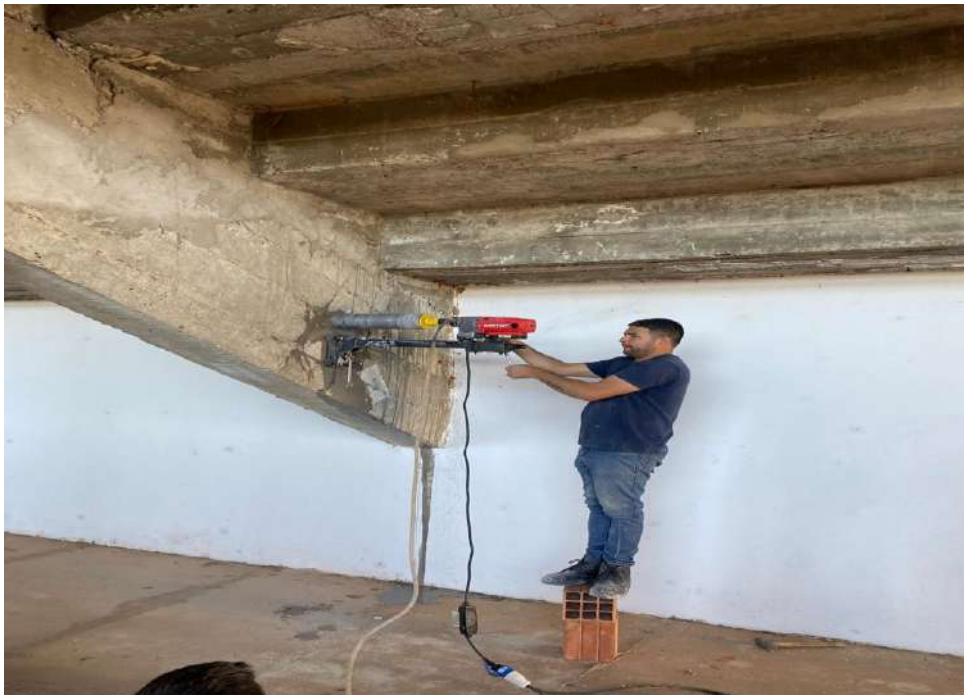
Ilustración D- 4: Extracción de probeta testigo. - Fuente: Elaboración propia.
