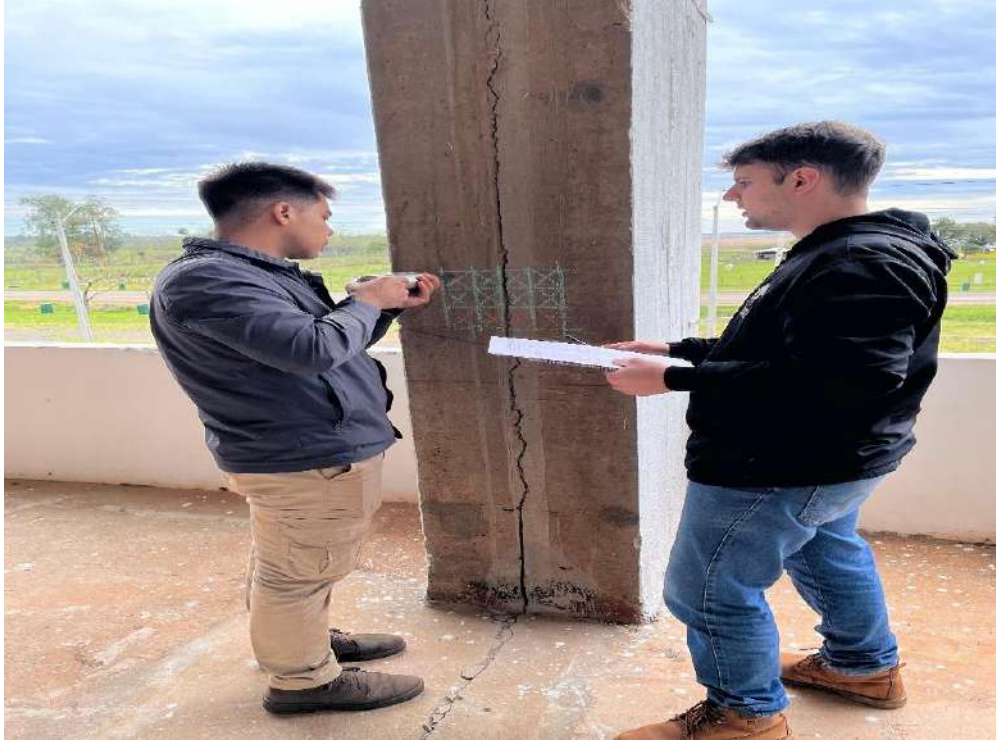
Ilustración B- 6: Realización del ensayo de esclerómetro. - Fuente: Elaboración propia.
