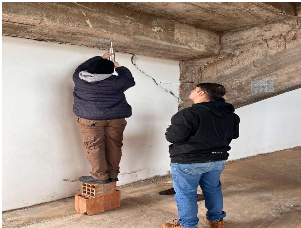
Ilustración B- 5: Realización del ensayo de esclerómetro. - Fuente: Elaboración propia.
