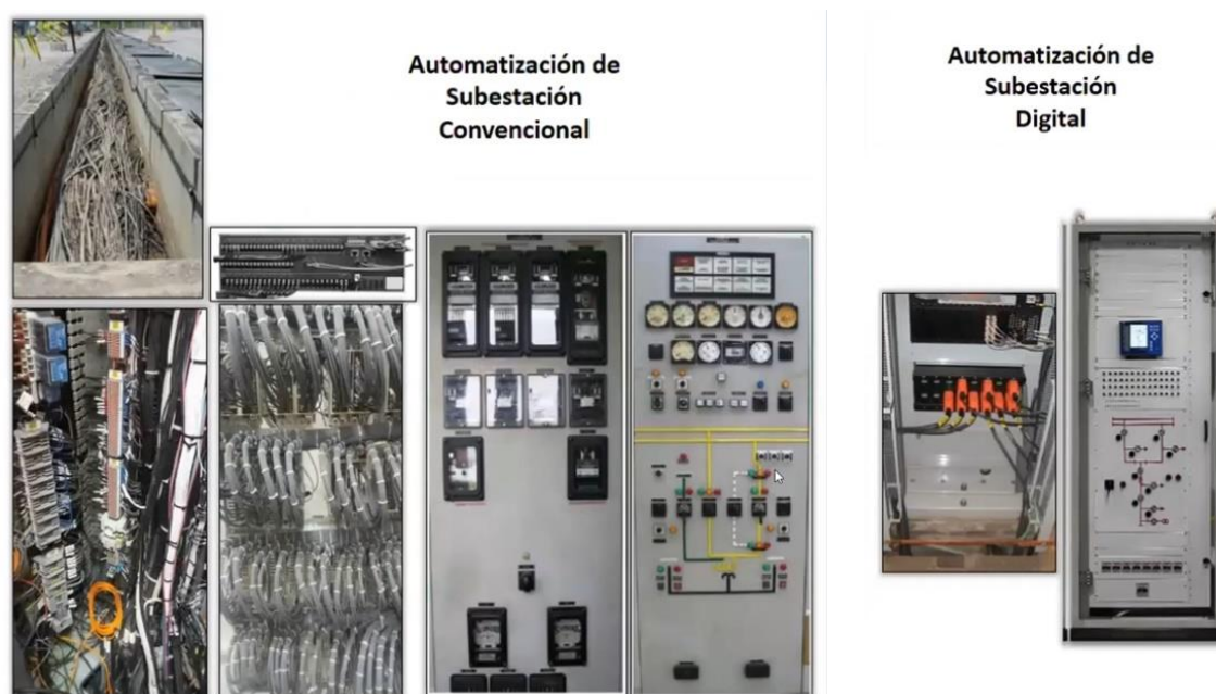
Figura 2.6: Nivel 1 y 2 de automatización de subestaciones
