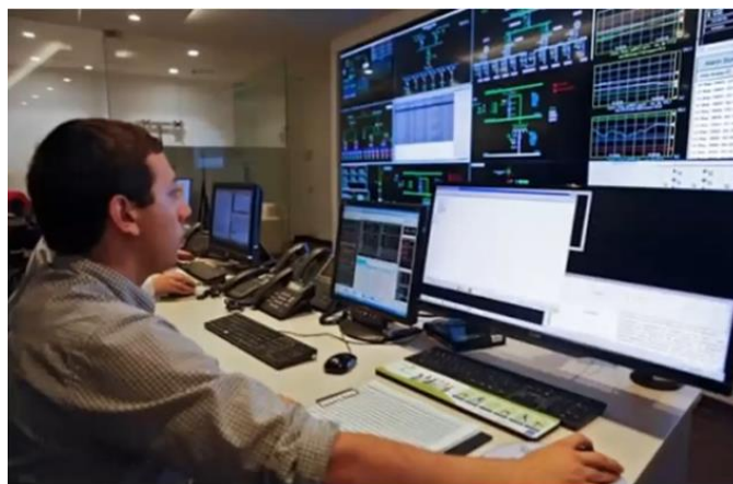
Figura 3.3: Nivel 3 de automatización de subestaciones
