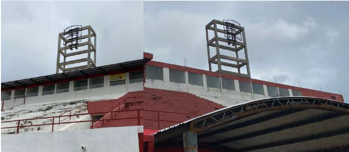
Figura 3. Estructuras de hormigón sobre la azotea
