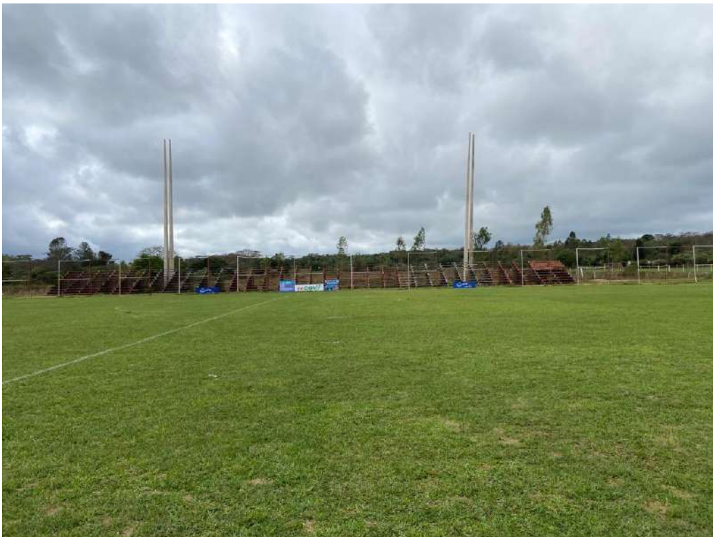
Figura 2. Columnas de hormigón colocadas en disposición lateral.
