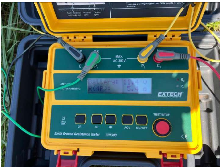
Figura 3: Medición realizada con el telurómetro
