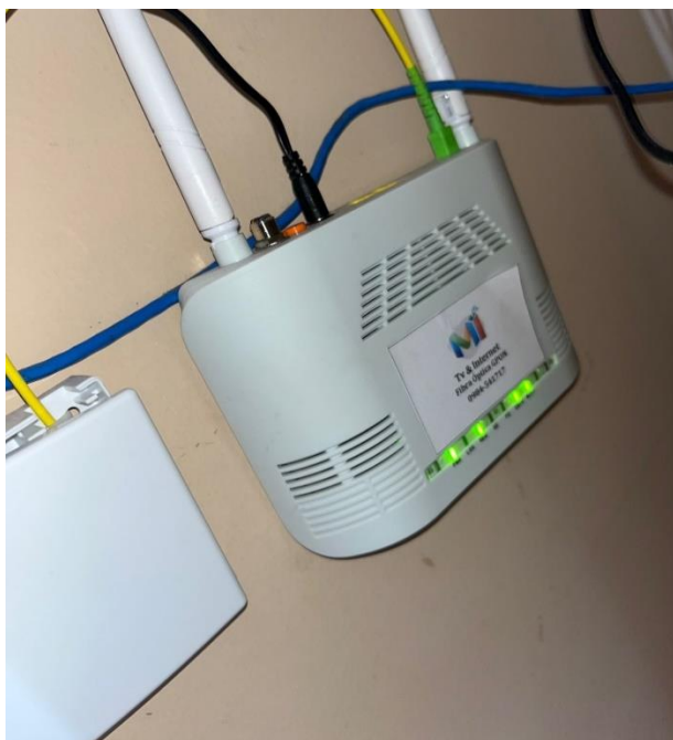
Figura 57. Proceso de Instalación dispositivos ONU-ONT
