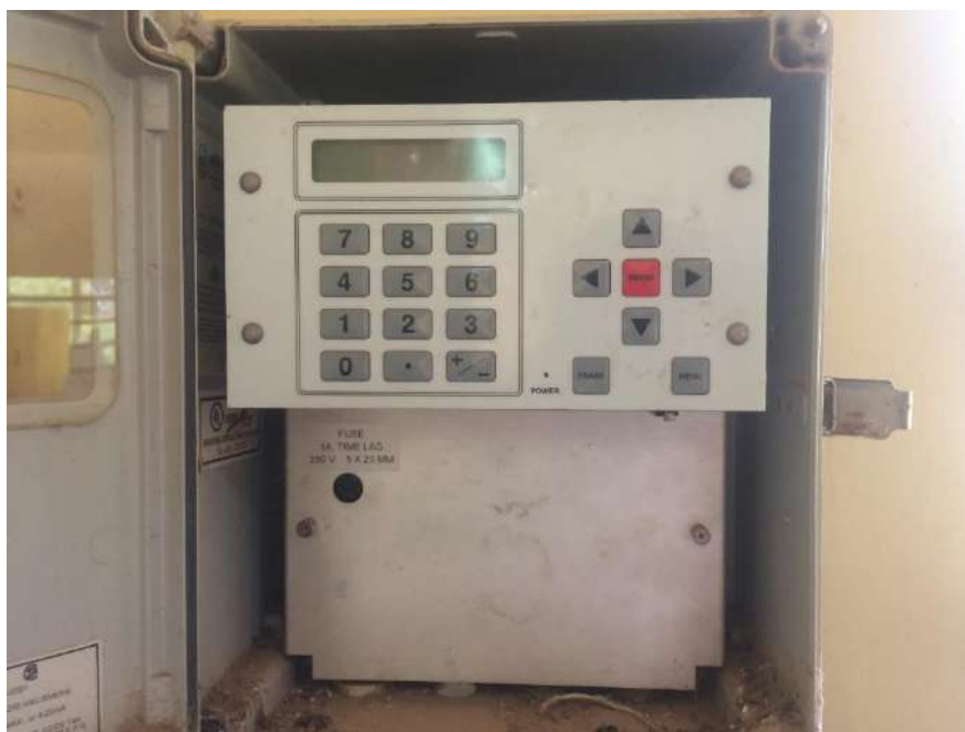
Figura 4.13: Caudalímetro Polysonics DCT6088
