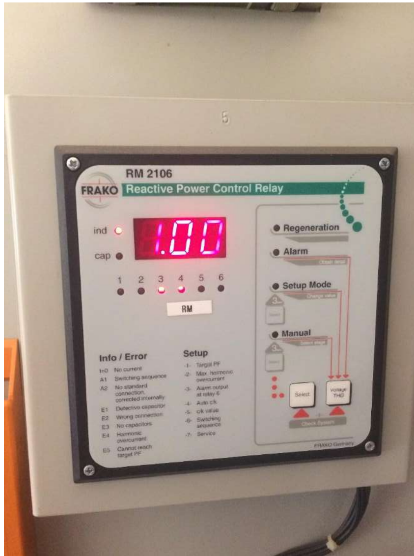
Figura 4.12: Banco de capacitores
