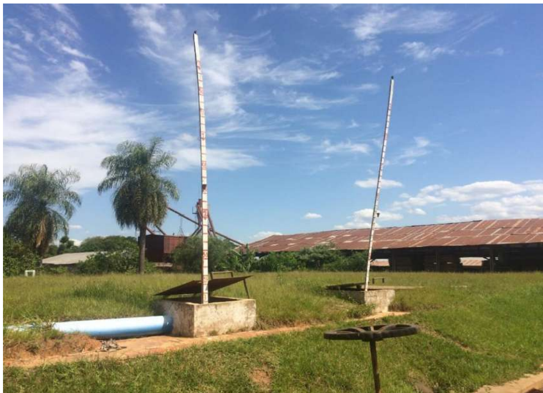
Figura 4.3: Medidores de nivel del reservorio
