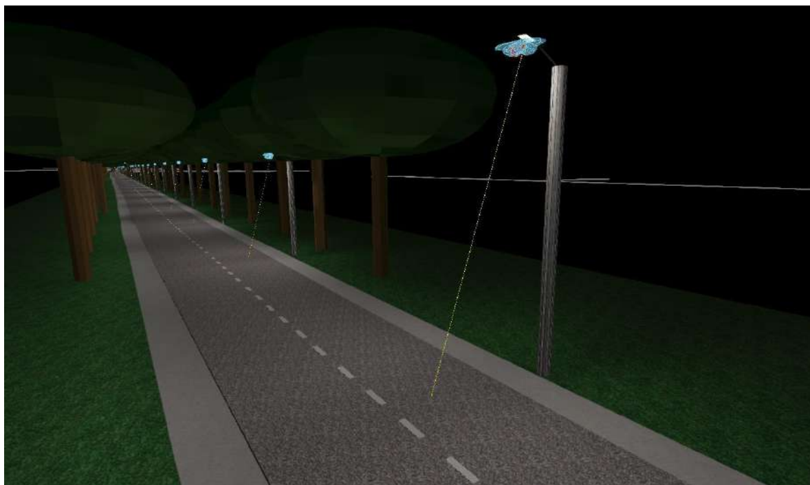
Figura 14. Vista del sistema de iluminación pública para tramo con calzada simple y alta densidad de vegetación.
