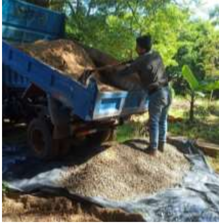
Ilustración 5 - Recolección de agregado fino
