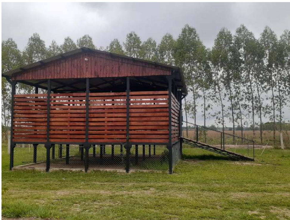
Figura 3 Vista lateral del galpon
