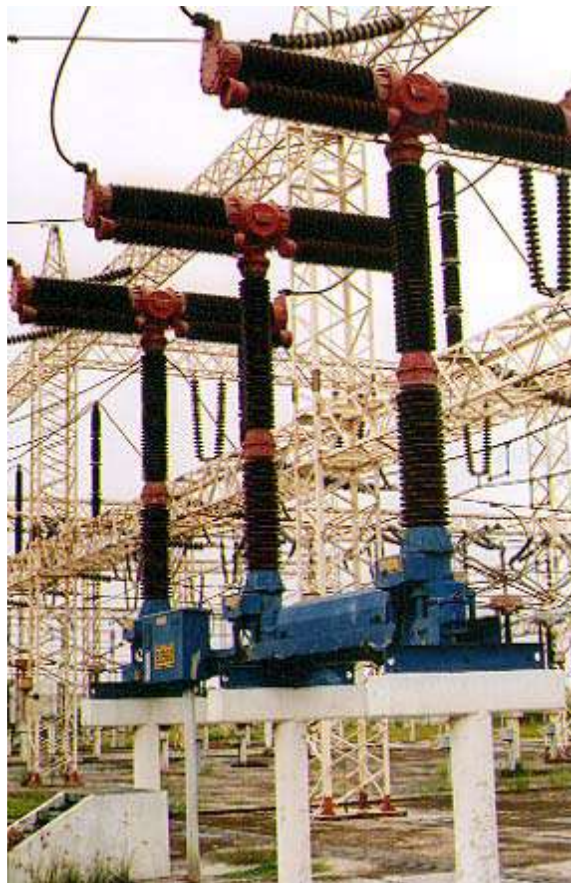
Gráfico 25. Interruptores de sopro de una presión
