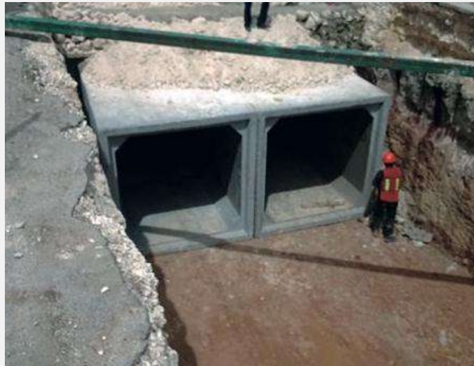
Alcantarilla celular doble 1,00 m x 1,00 m
