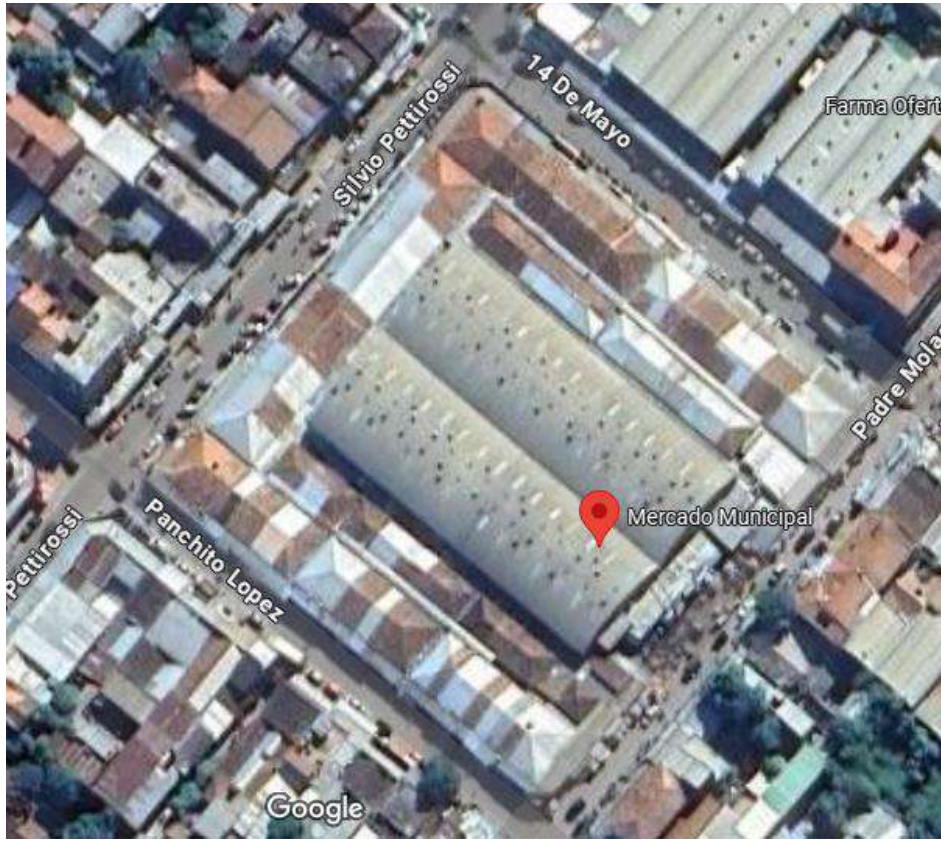
Figura 2. Centro Comercial N°1. Vista satelital.
