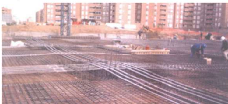
Figura 3.3 – Refuerzos y ductos de postensado en el primer nivel.
