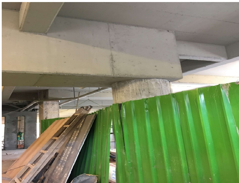
Figura 1.3 - Edificio Life en la actualidad. Techo estacionamiento en planta baja, con vigas de 0.7x1.1m. Fuente: Petra Urbana
