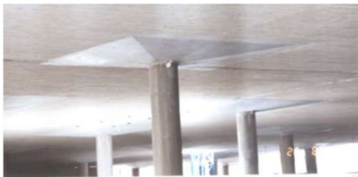
Figura 3.2 – Vista de los ábacos. Fuente: Post-tensioning in buildings - Reporte técnico de la Fédération Internationale du Béton (FIB) 2005. Página 47.
