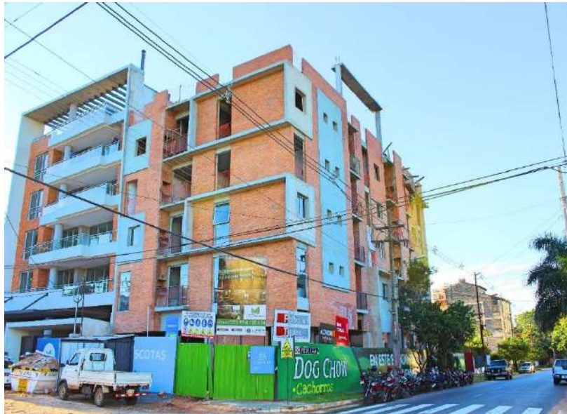
Figura 1.2 - Edificio Life en la actualidad. Fuente: Petra Urbana
