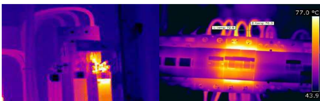
Figura 3.7: Distribución de temperatura dentro de un tablero.
