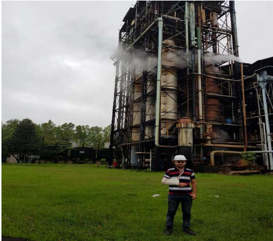
Figura A.2.5: Sector destilería.
