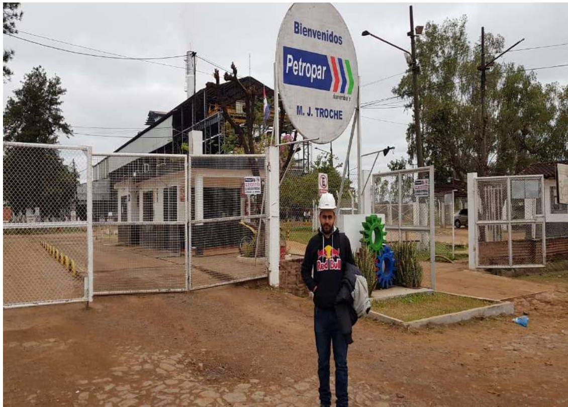
Figura A.2.3: Acceso principal en la planta alcohólica.
