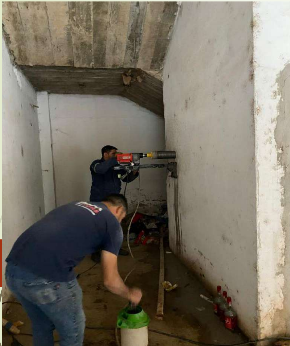
Proceso de extracción de las probetas- Fuente: Elaboración propia.
