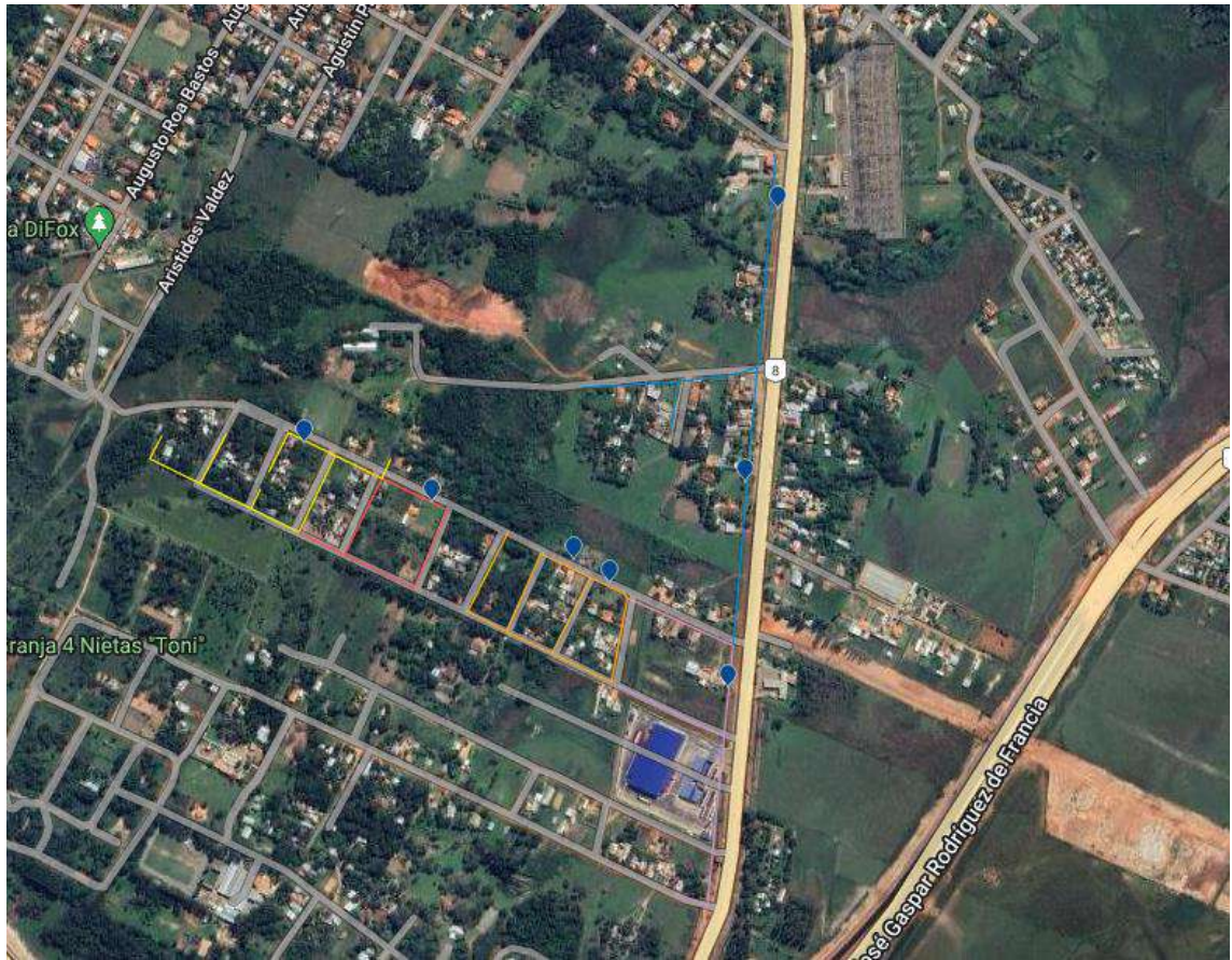
Figura A.2: Vista General de Puesto de Distribución del Alimentador COV1.
