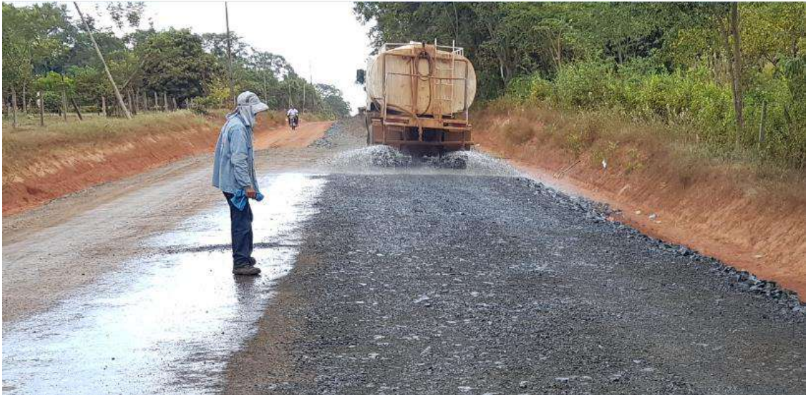
Ilustración 17: Imprimación de la capa superior de macadam.
