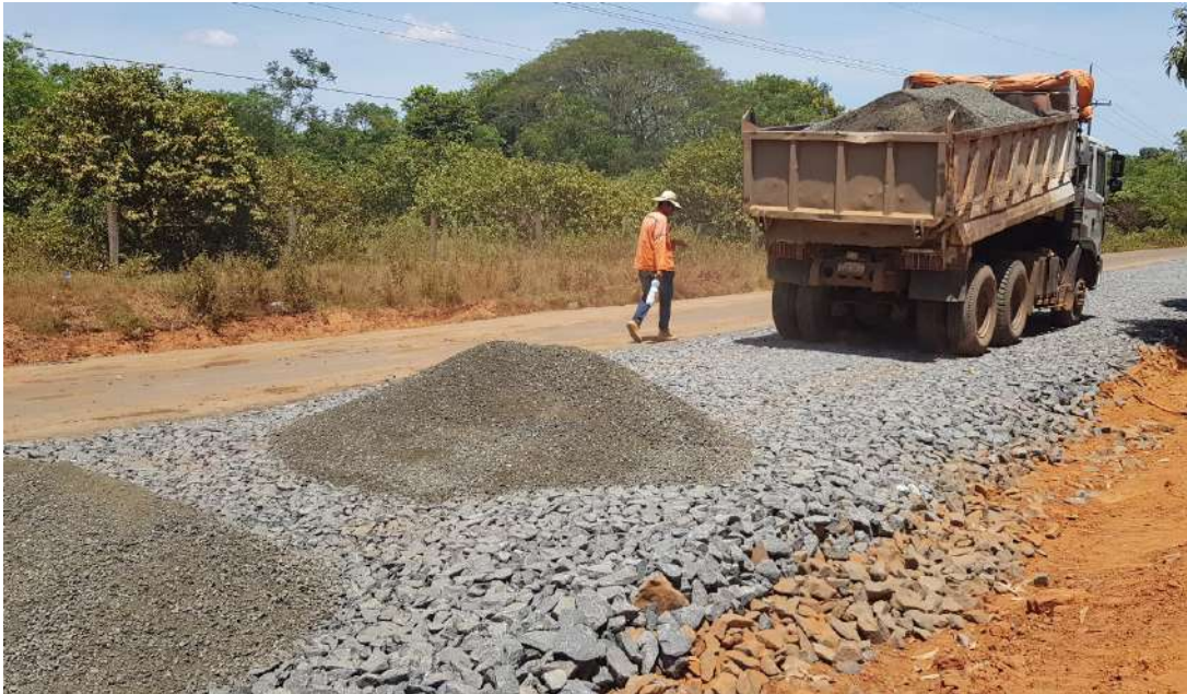
Ilustración 11: Riego y compactación del material de relleno
