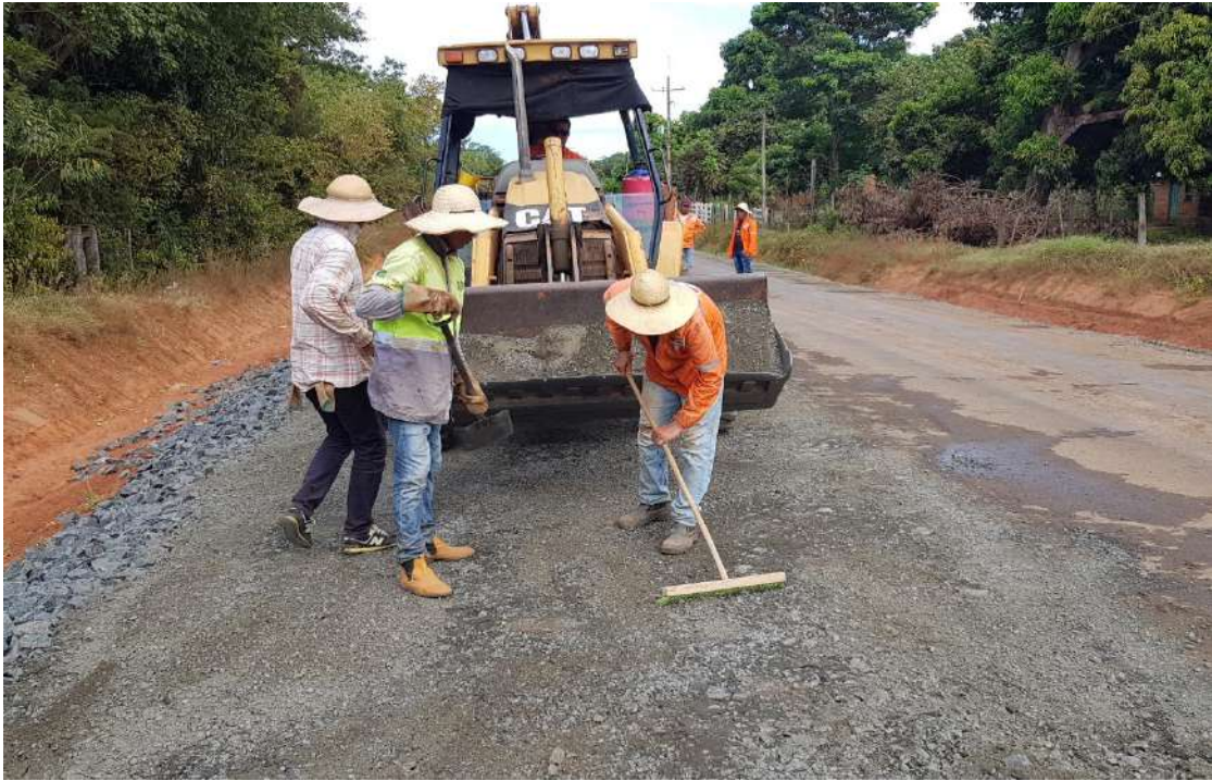
Ilustración 15: Compactación del material de relleno segunda capa
