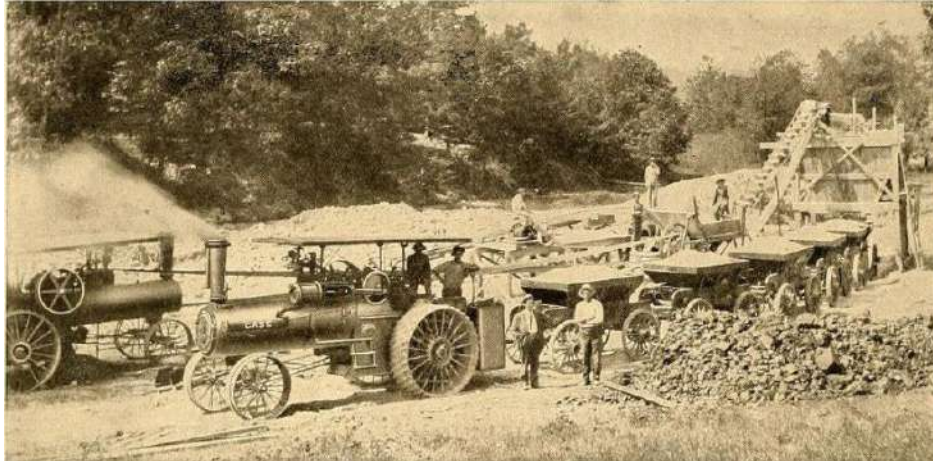
Ilustración 31: El transporte de macadam desde el machacador en cantera en 1910
