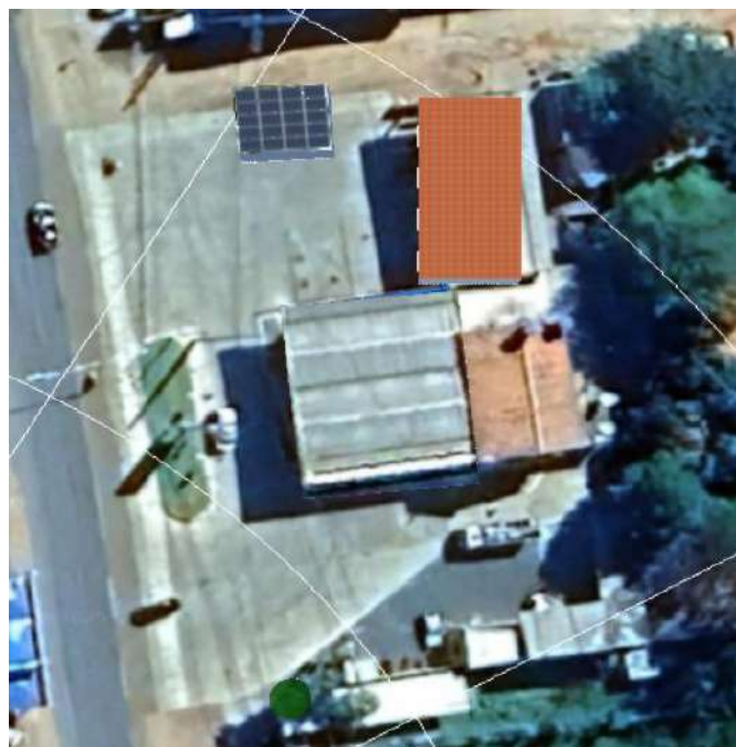
Figura 12: Estación de Servicio Puma Liberación orientación de la estructura lado norte.
