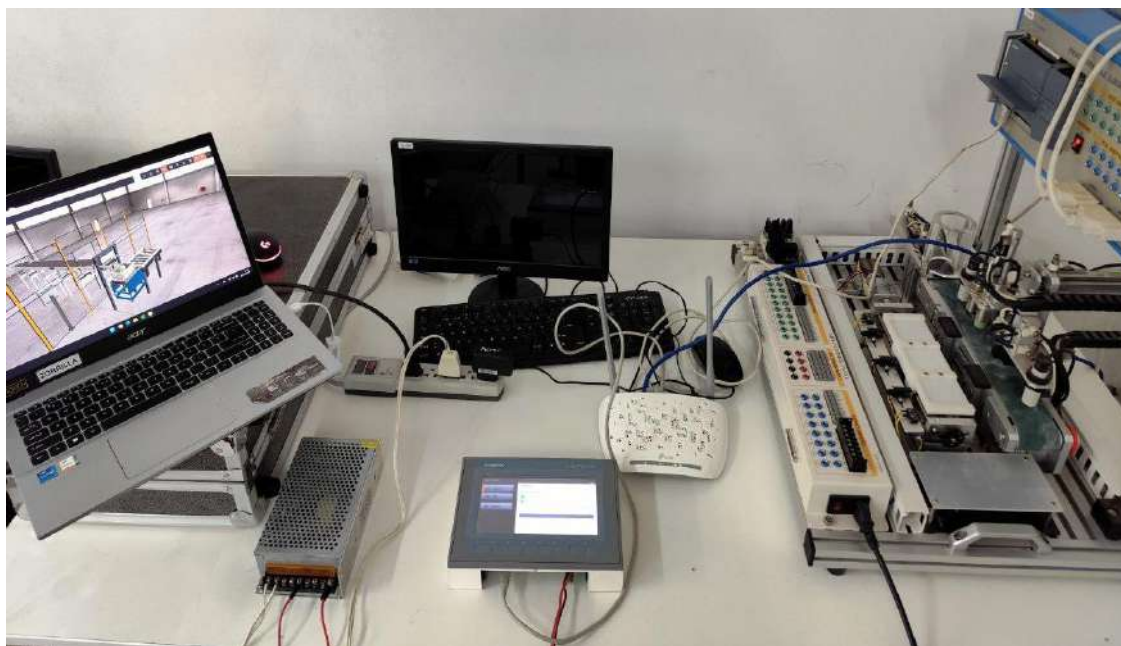
Figura 6.31 Comunicación por protocolo PROFINET/Ethernet Industrial con equipos físicos.
