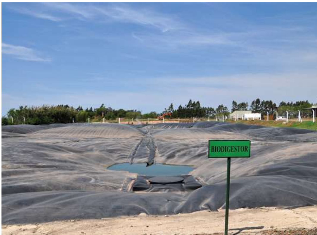
Ilustración 5: Biodigestor de Laguna cubierta de media-baja tecnología.
