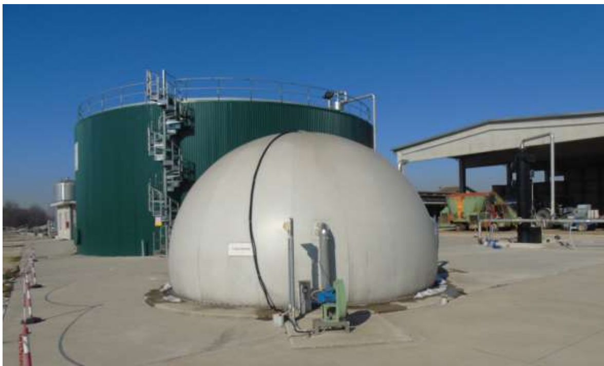
Ilustración 6: Biodigestor de mezcla completa de alta tecnología.
