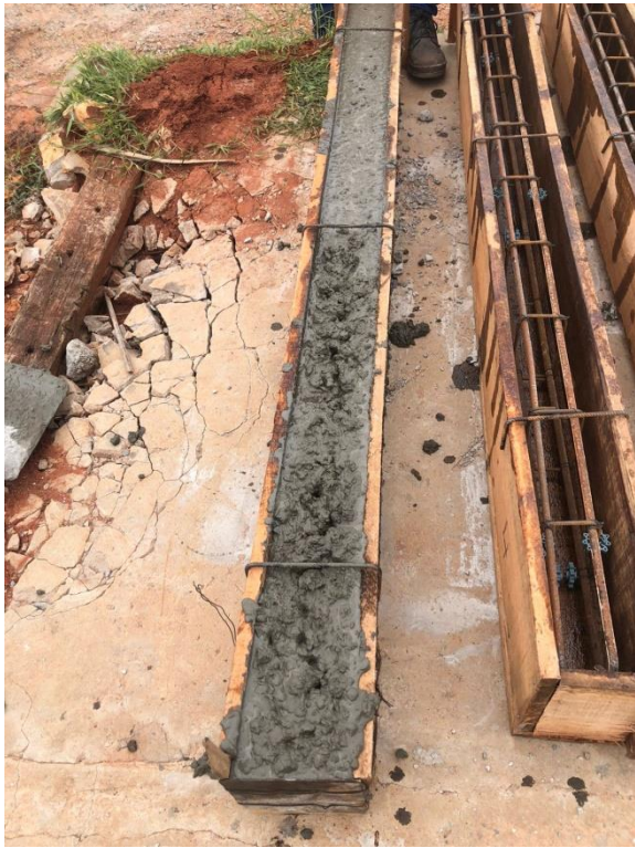
Proceso de carga de mezcla a encofrado
