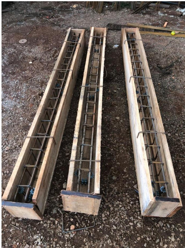
Encofrado de Viga de Hormigón
