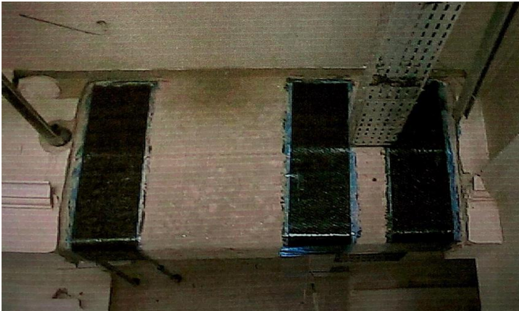
Ilustración 3 - Refuerzo de viga a cortante
