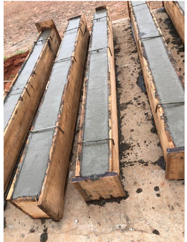
Encofrado de Viga de Hormigón
