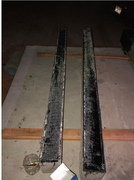
Refuerzo a Flexión Fibra de Carbono
