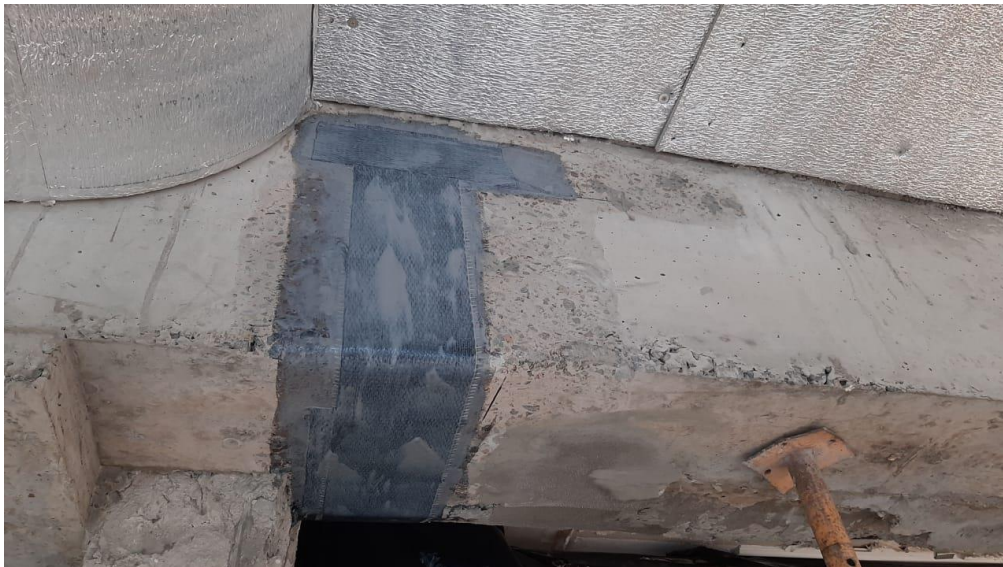
Ilustración 4 - Refuerzo de estribos
