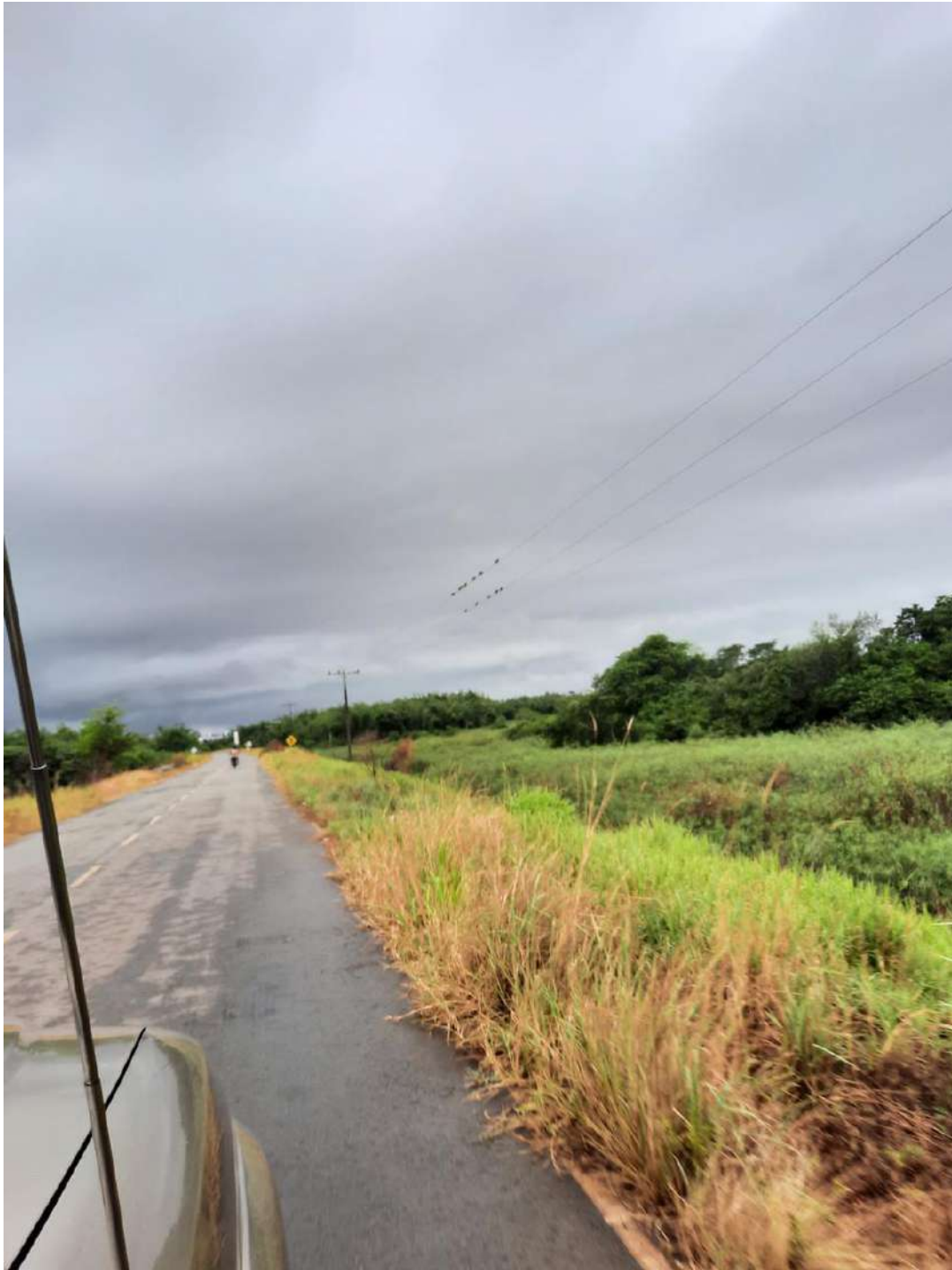
Anexo 3.1. Relevamiento post lluvia: Tramo 1
