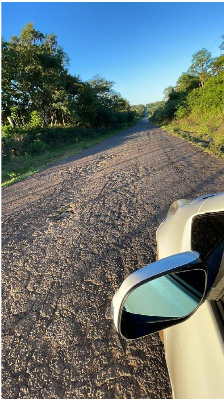
Anexo 1.1. Visualización de falla Piel de cocodrilo
