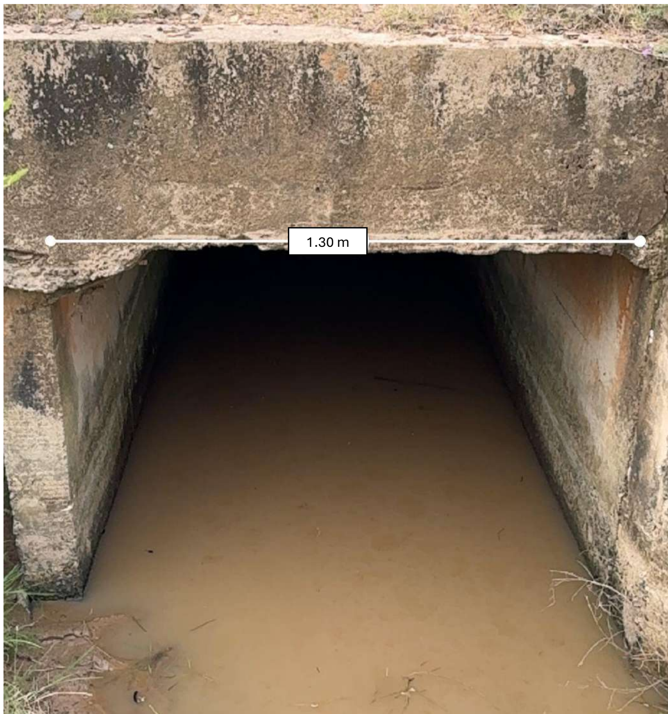
Anexo 3.4. Dimensiones del alcantarillado
