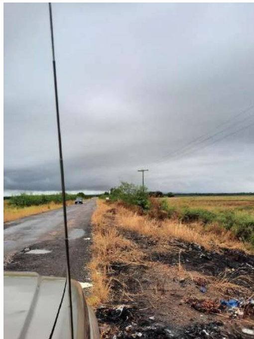
Ilustración 6: Inspección in situ de drenaje
