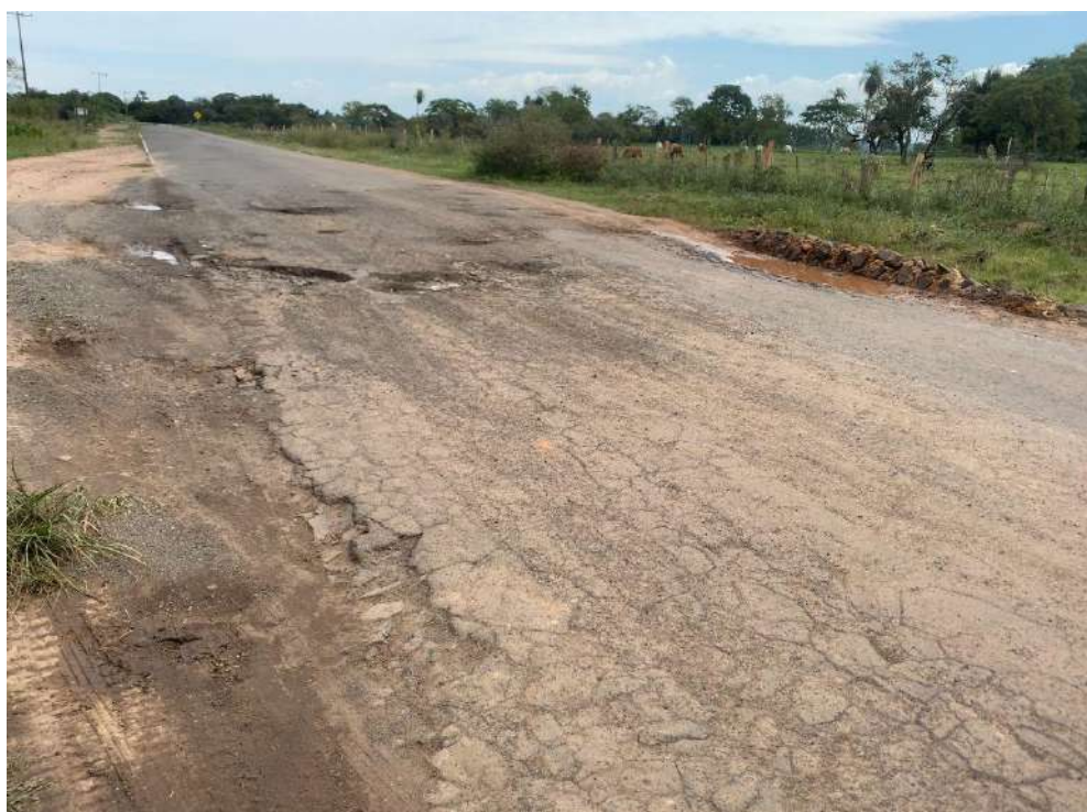
Anexo 1.3. Visualización de baches y hundimientos
