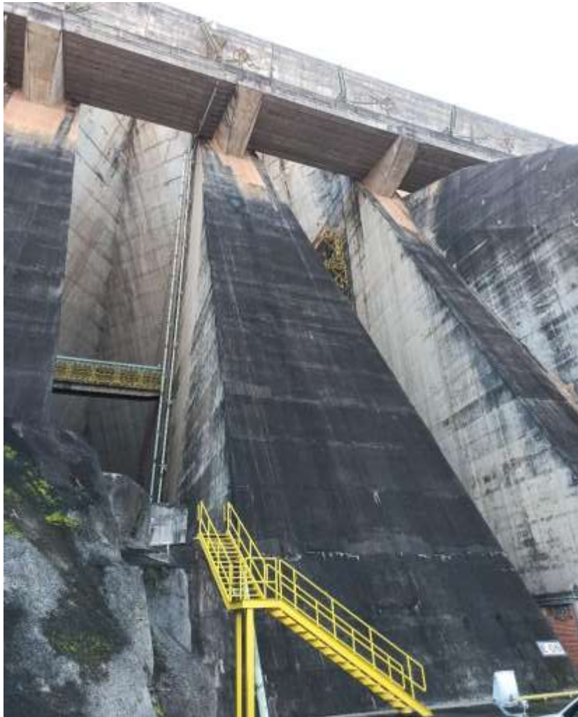
Figura 38 - Bloque E-06. Fase aguas abajo.
