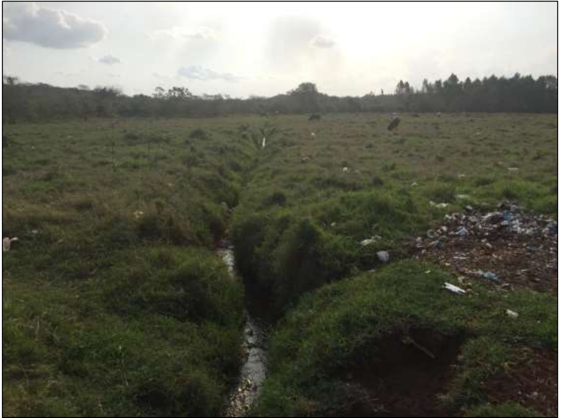
Fig. 3.6: Cauce de drenaje de la cuenca al arroyo
