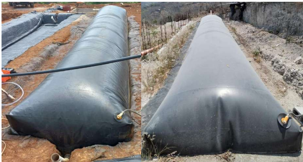
Figura 6. Biodigestor tipo Taiwán
