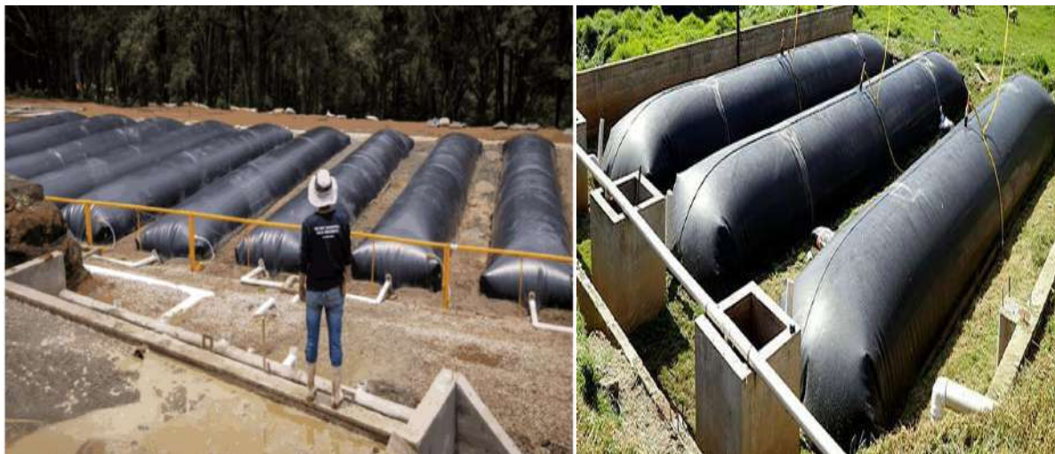
Figura 8. Biodigestores en serie
