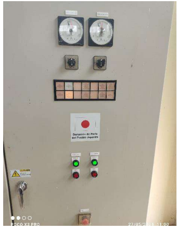
Figura 17: Panel de Control de la Sala de Bombeo
